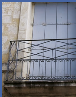
➔ Surélévation neuve d'un balcon ancien.
