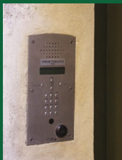
▮ L’interphone doit s’encastrer à l’intérieur du tableau du mur.
