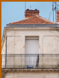
Toiture en croupe sur angle du bâtiment.
