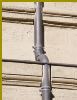
La descente cintrée s’encastre parfaitement dans les moulures.
