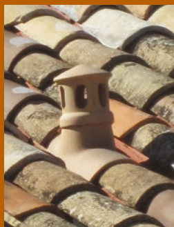
! Sortie de ventilation en terre cuite.
