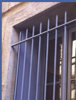
➔ Grille neuve placée dans l'épaisseur du mur.
