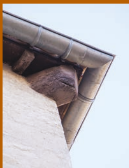
■ Débord de toit en bois, l'élément d'angle a été scié.
