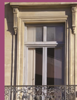
XX e siècle, imposte à deux carreaux, vitrage grand jour, soubassement plein.
