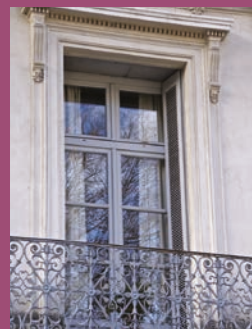
XIX e siècle, imposte à deux grands carreaux, soubassement plein.
