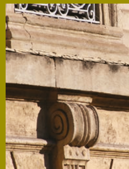
Les câbles sont regroupés au-dessus de la moulure du bandeau et peints en beige du ton de la pierre.
