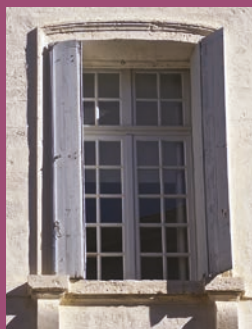
Croisée XVIII e siècle en bois avec petits carreaux.
