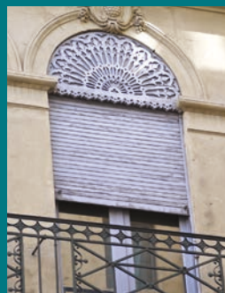
Store en bois, derrière lambrequin.
