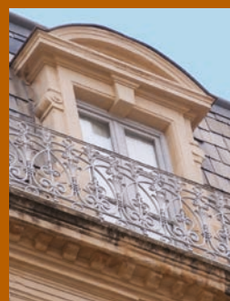
▮ Lucarne d'une toiture haussmannienne.
