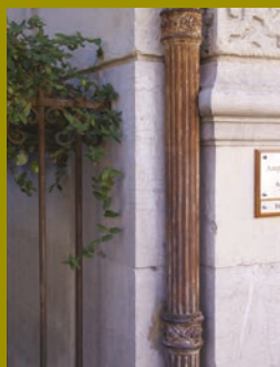
▮ Descente d'eau en fonte cannelée. XIX e siècle.
