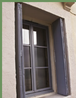
| Fenêtre et volets posés en feuillure de la maçonnerie.
