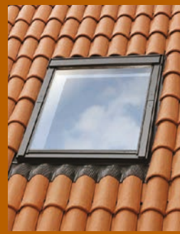
! Châssis de toit.
