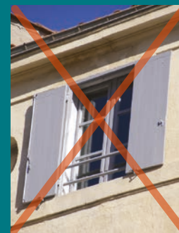
➔ Volets battants entre le bandeau d'étage et le bandeau sous toiture.
