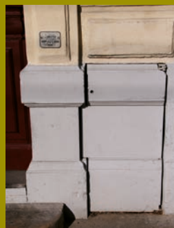
Le coffret est encastré dans le soubassement. Le décor a été restitué dans la porte.
