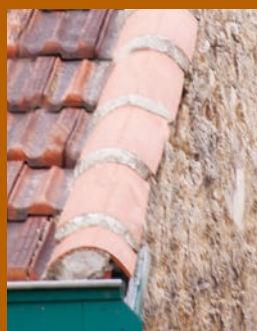
▮ Rive maçonnée en tuiles rondes sur une couverture en tuiles de Marseille.
