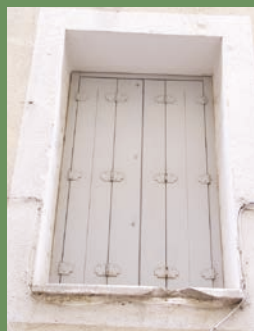
| Volets posés dans le tableau sur une tapée en bois.
